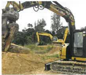
車両系 (解体用)
